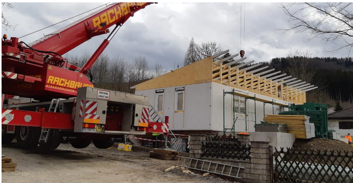
Foto 1: Die Baustelle in Schörfling am Attersee. Foto: KFS / Antje Haag
