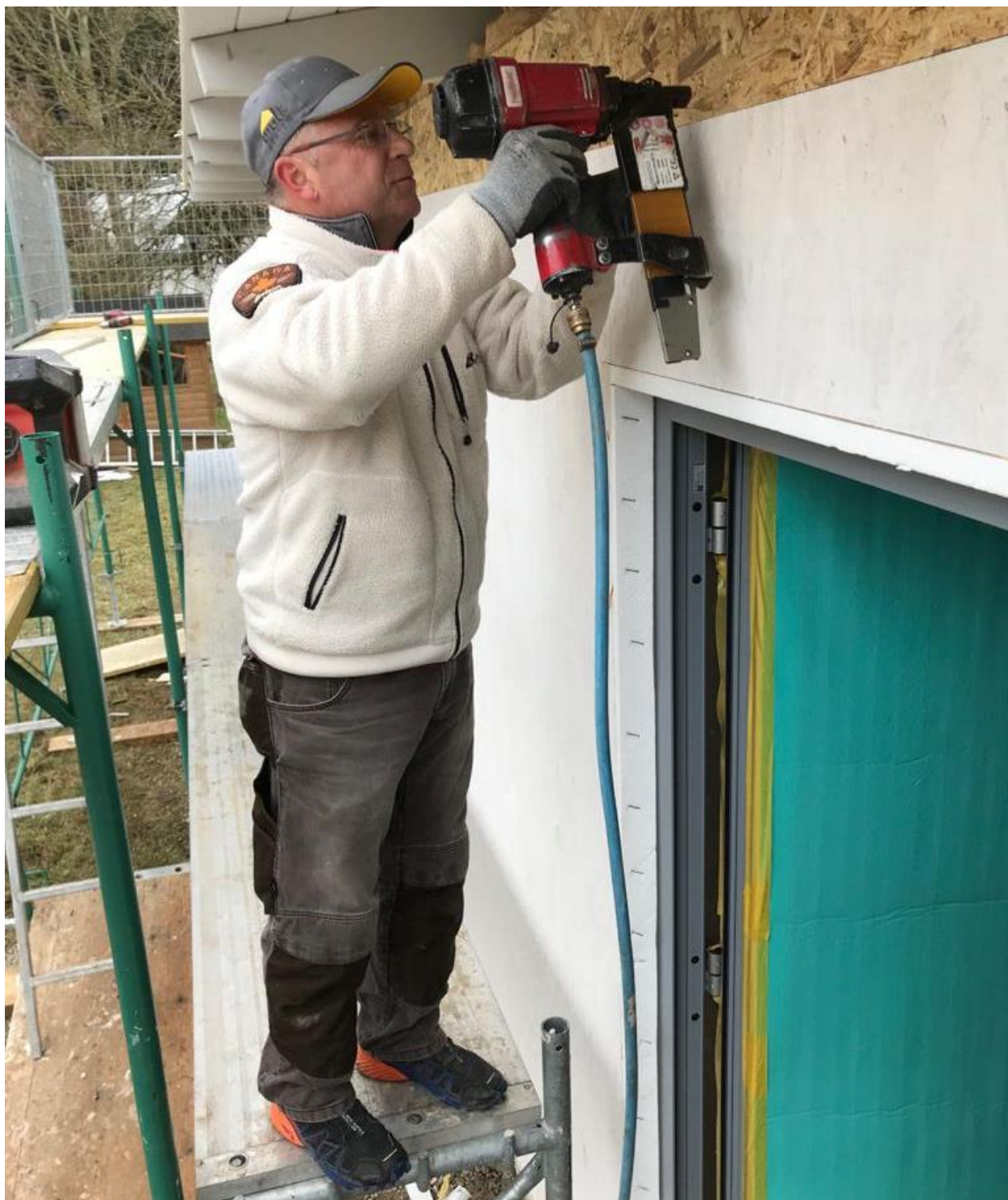
Foto 4: Auch Sektionsleiter Mario Fenzl ist voll Eifer und Elan auf der Baustelle. Foto: KFS / Roland Rappold
